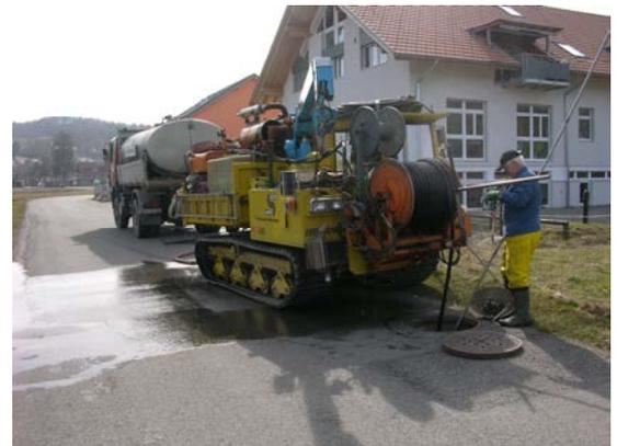
Kanalreinigung mit speziellem Fahrzeug
