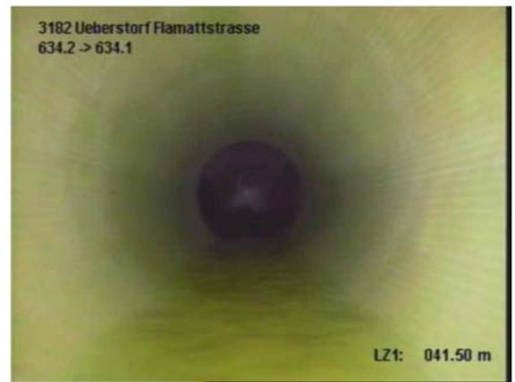
Verbandskanalsanierung mit Inliner
