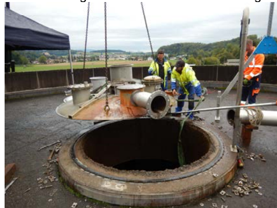
Demontage der alten Gashaube
