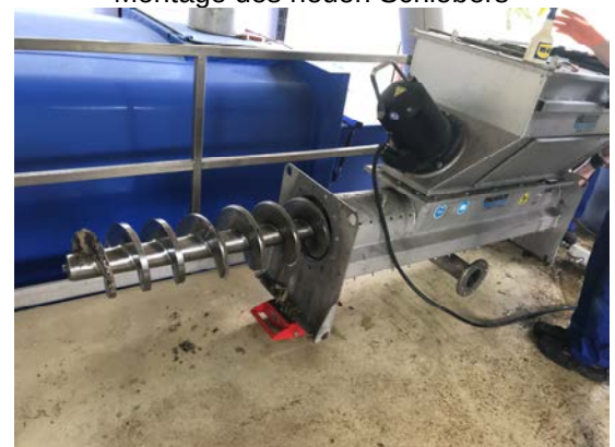
Demontage der Rechengutpresse
