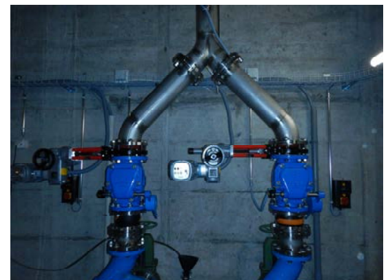
Neue Aggregate und Chromstahlleitung
