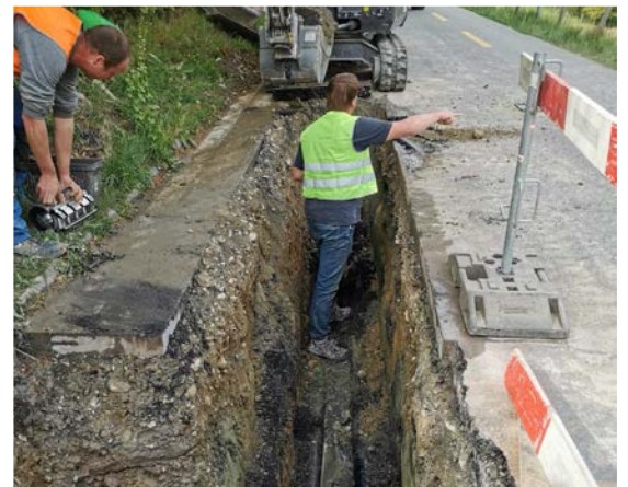
Reparatur der Druckleitung PW Stegrain
