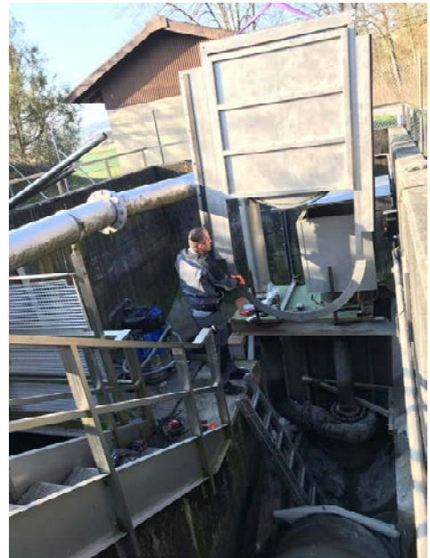
Montage des neuen Schiebers
