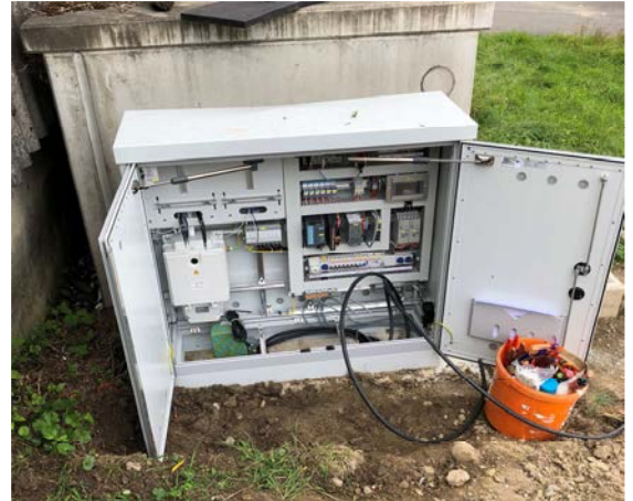
Neubau des Schaltschranks PW Balsingen
