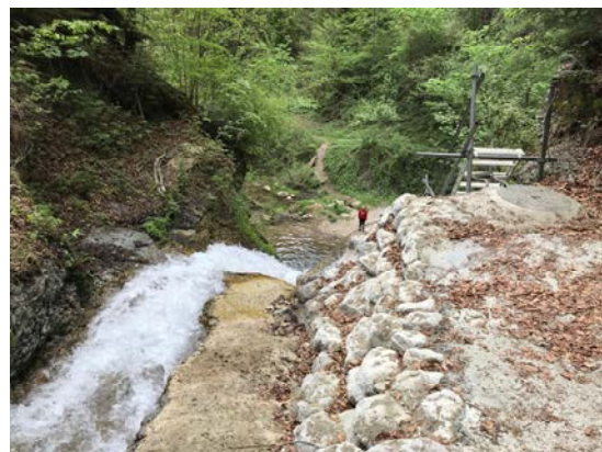
Reparierter Schacht im Scherligraben
