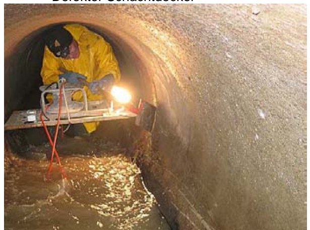
Örtliche Reparatur im Kanal
