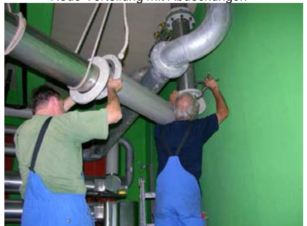
Umbau der Hygienisierung
