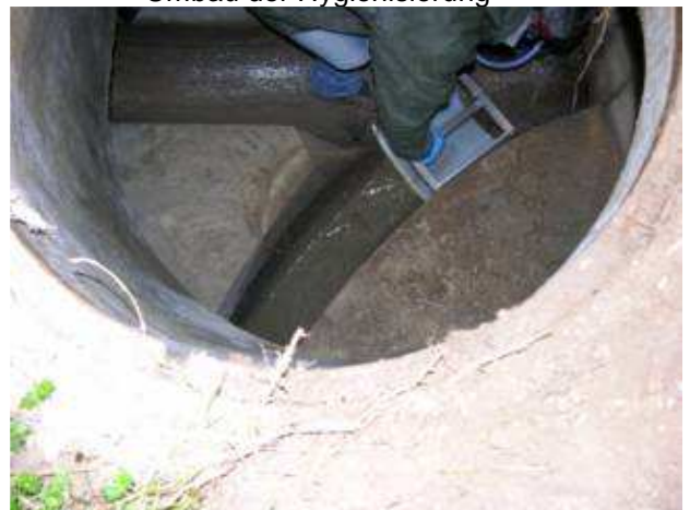
Fremdwassermessung in einem Schacht
