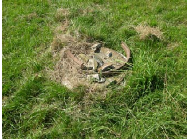
Defekter Schachtdeckel
