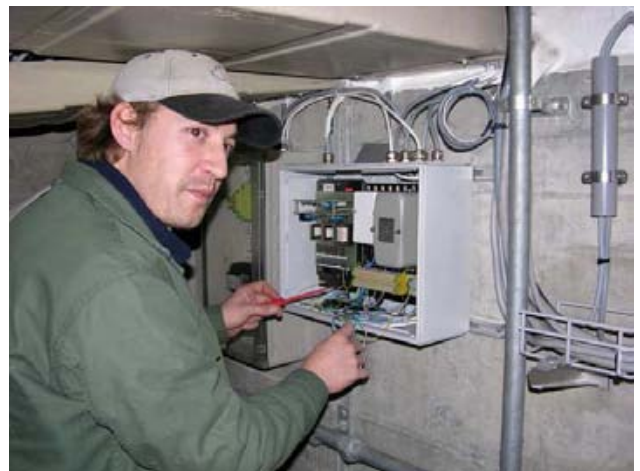
Umbau der Unterverteiler
